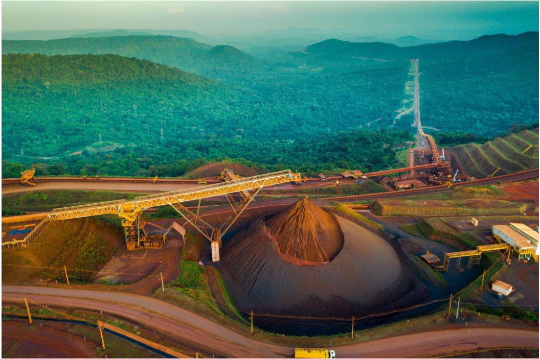
Figura 5 – Vista aérea da estação de beneficiamento do minério de ferro no Complexo S11D da Vale, ao fundo a Flona de Carajás, Canaã dos Carajás, Pará, 2020.
