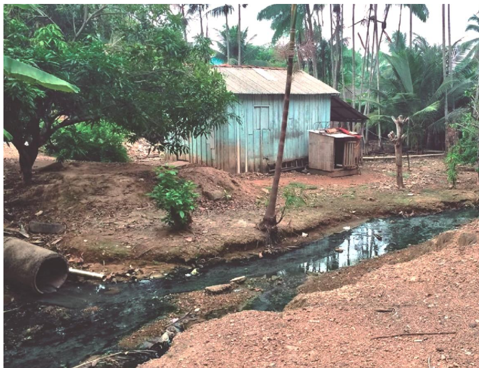
Figura 4 – Imagem de residência unifamiliar ao lado de rede aberta de drenagem, Marabá, Pará, 2015.
